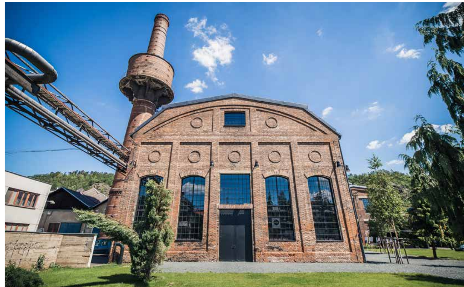
Revitalizace areálu v Libčicích nad Vltavou Foto: CzechInvest
